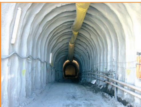
Vista de la sección libre de la galería excavada y revestida.
