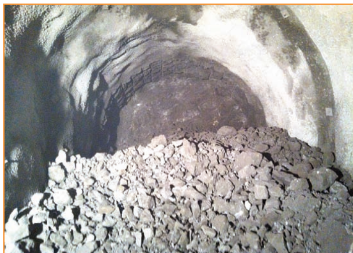
Material de la sección excavado por la voladura.
