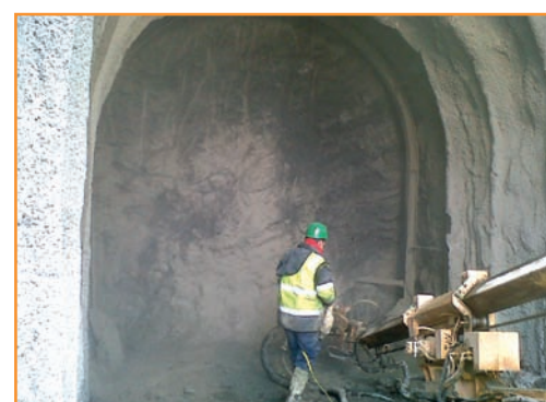
Gunitado de las paredes de la galería tras el desescombro y colocación de cercha.
