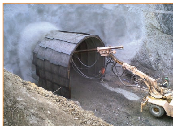
■ Gunitado del talud frontal del emboquille.
