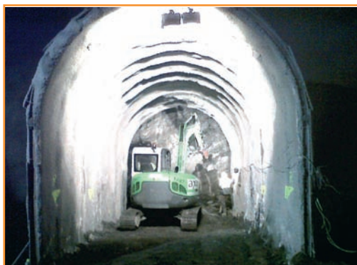
Excavación mecánica mediante retroexcavadora y martillo en frentes más débiles.
