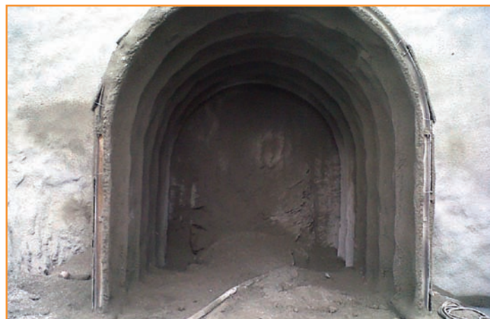
■ Vista del frente inicial en el emboquille de la galería.
