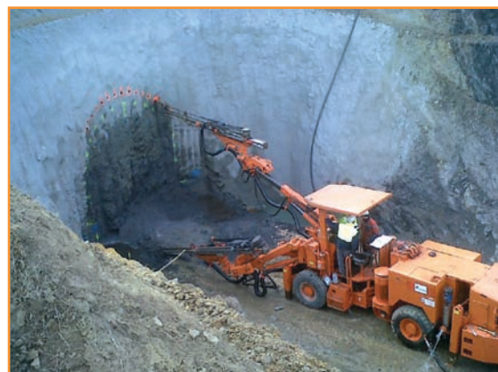
■ Ejecución del paraguas de micropilotes mediante jumbo en el emboquille.
